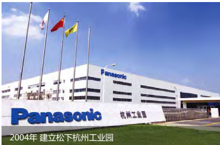
2004年 建立松下杭州工业园
